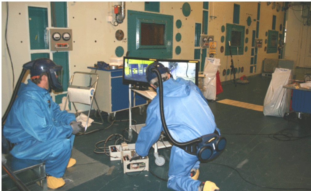
Ved hjælp af kamera og skærm fjernes radioaktive kilder fra væggen og gulvet i Hot Cell med fjernbetjent udstyr.
