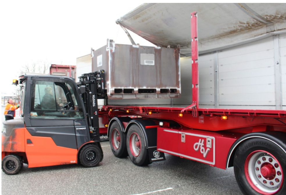
Figur D1.7. DD Type-2 containere læsses til afhentning af affald fra cyklotronbunker nedrivning i Aarhus 2026.
