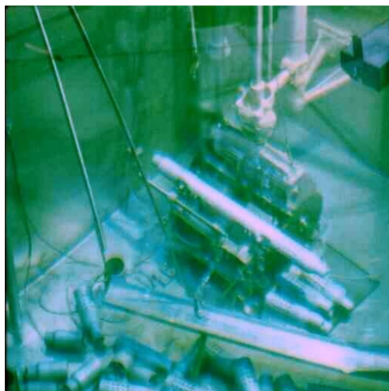
Figur 10.2. Skæring af et brændselement i skærebassinet i AH-hallen på DR 3.
