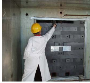
Foto 1 Termisk kolonne med grafit
