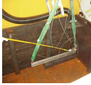
Foto 2 Grafit dragere fjernes ved brug af vakuum løfte anordning
