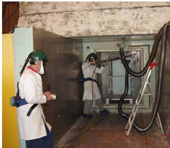
Foto 5 Plasma skæring af blynæse med afskærmning
