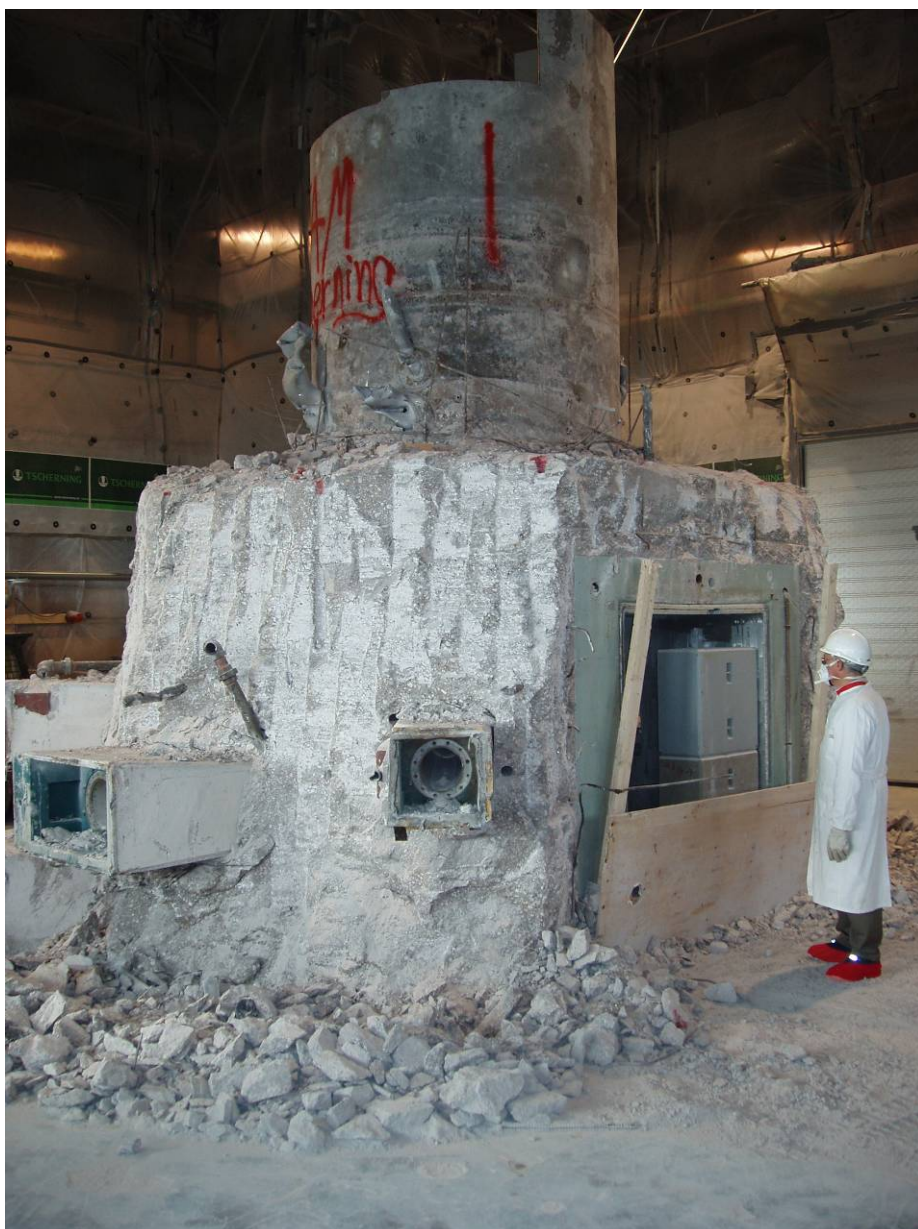
Figur 63 Procestrin 5 er afsluttet. Aktiveret del af beton er "blotlagt".
