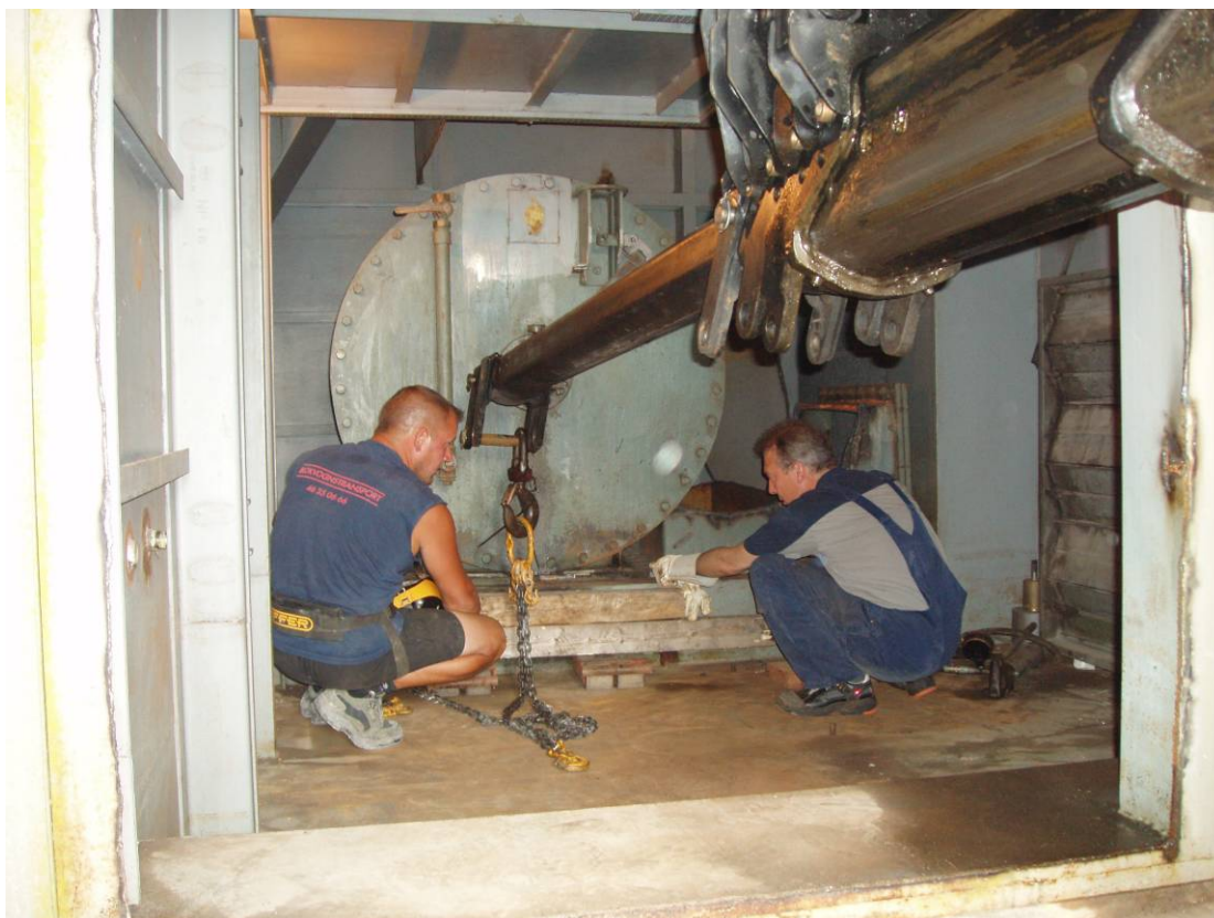
Figur 8 Forberedelse til udtagning af Gako ventil.
