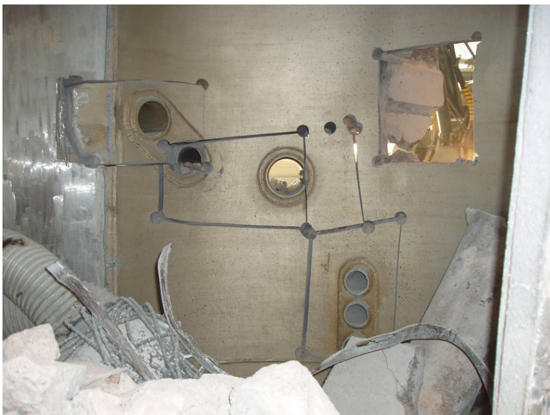
Figur 61 Reaktortank set indefra under udskæring af vandrette rørklodser.
