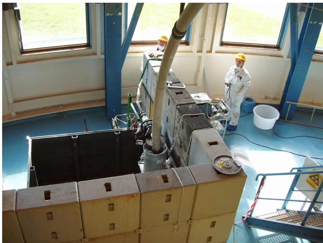
Figur 22 Opstilling af fjernbetjent saks over container. Der er monteret kamera direkte på saksen. Monitor er placeret uden for afskærmning.
