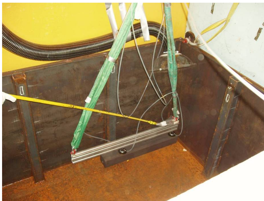
Figur 27 En Grafitstringer fjernes ved brug af vakuum løfteanordning og placeres i DD stålcontainer
