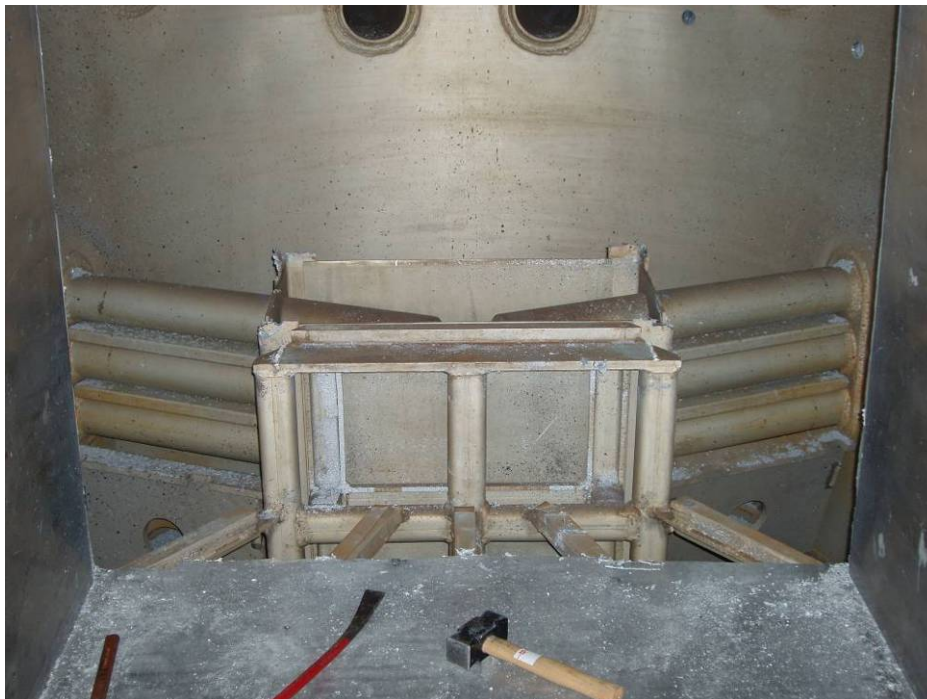
Figur 35 Resterende indvendig konstruktion efter fjernelse af gitterplade. Blykapper over instrumentrør er fjernet.
