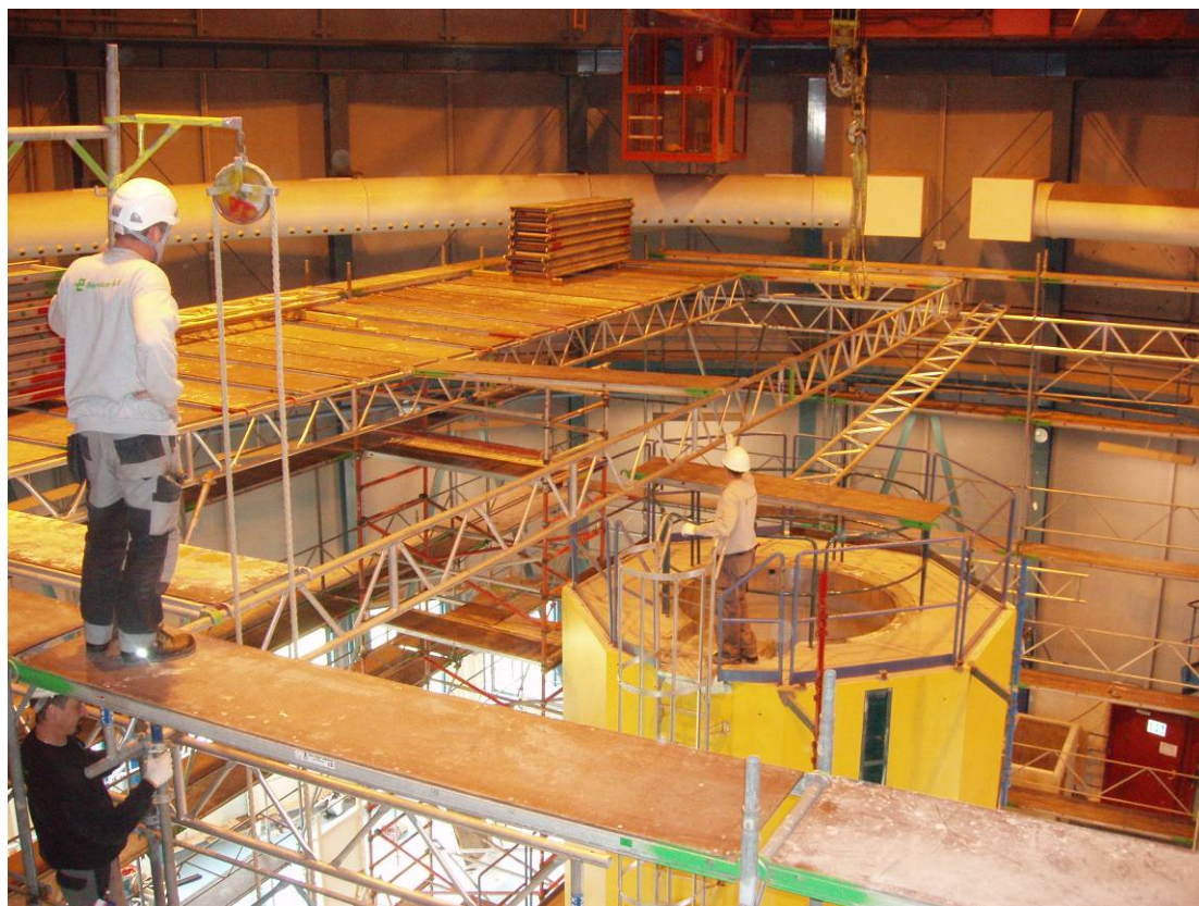
Figur 43 Stillads opsættes omkring reaktor
