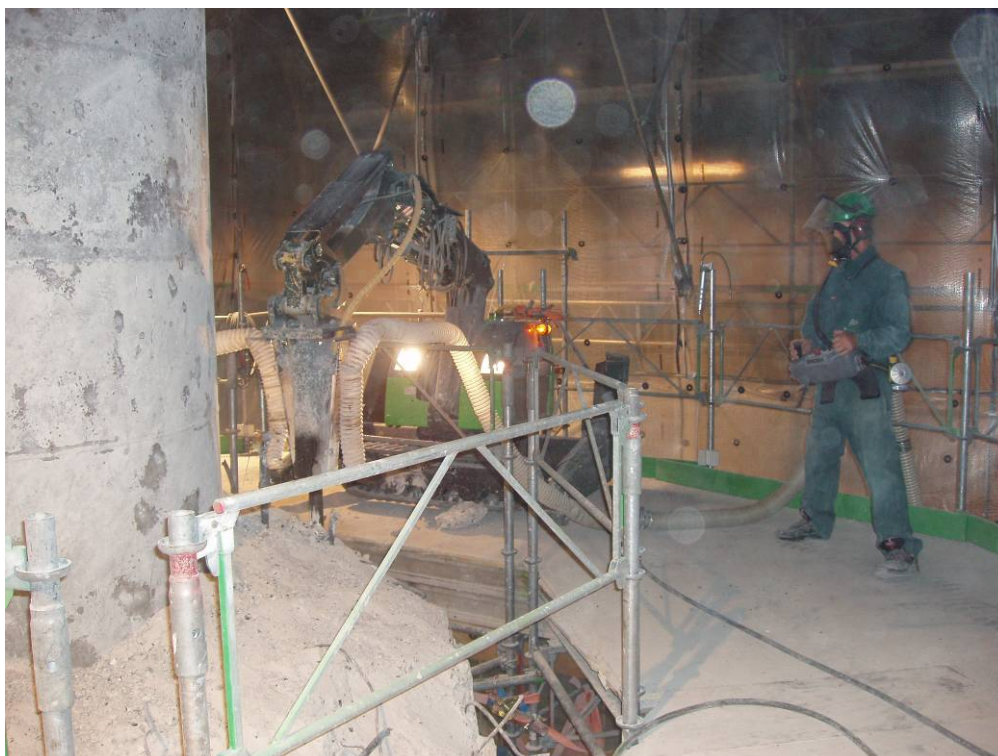
Figur 52 Nedbrydning af skorsten fra platform. Fjernstyret nedbrydningsrobot 'Brokk90' i aktion.
