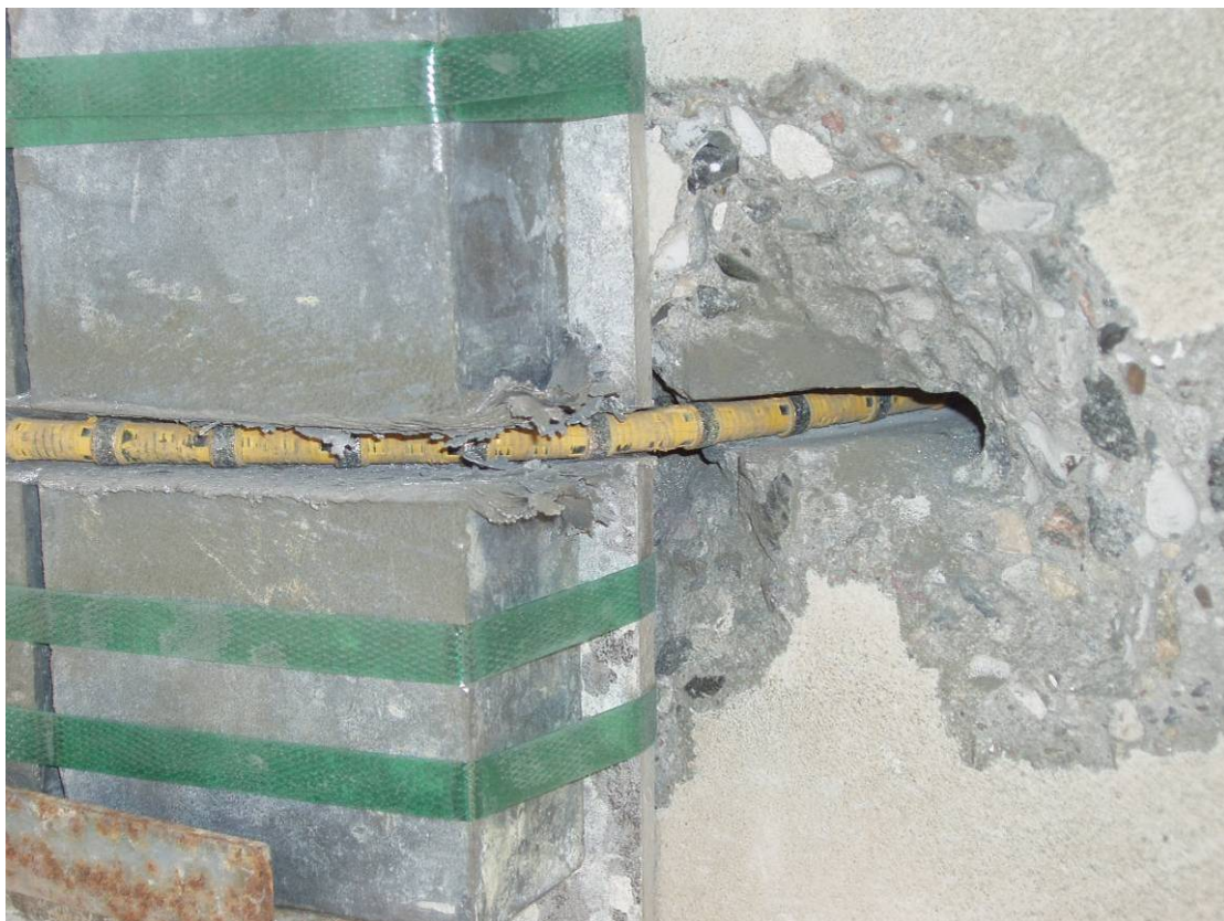
Figur 58 Eksempel på skæring i bly med wire.
