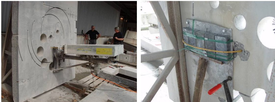
Figur 57 Opstilling af testkonstruktion til forsøgsskæring med wire.
