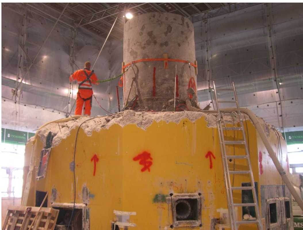
Figur 56 Øvre del af reaktorblok nedhugget og forberedelse til nedskæring af reaktortank.
