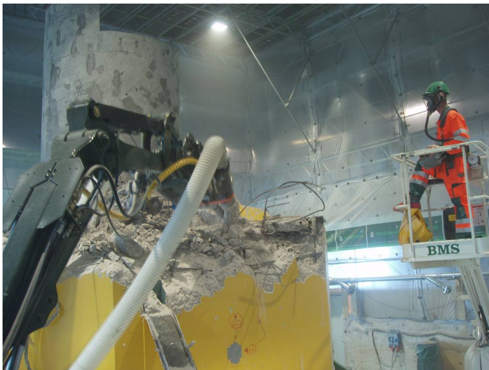
Figur 55 Nedbrydning af øvre del. Nedbrydningsrobot 'Brokk330' fjernstyres fra lift.
