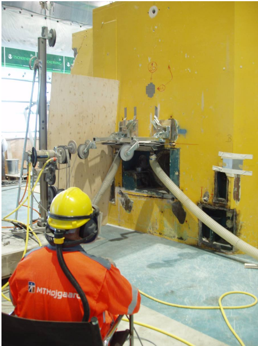
Figur 59 Udskæring af vandrette rør med wire.
