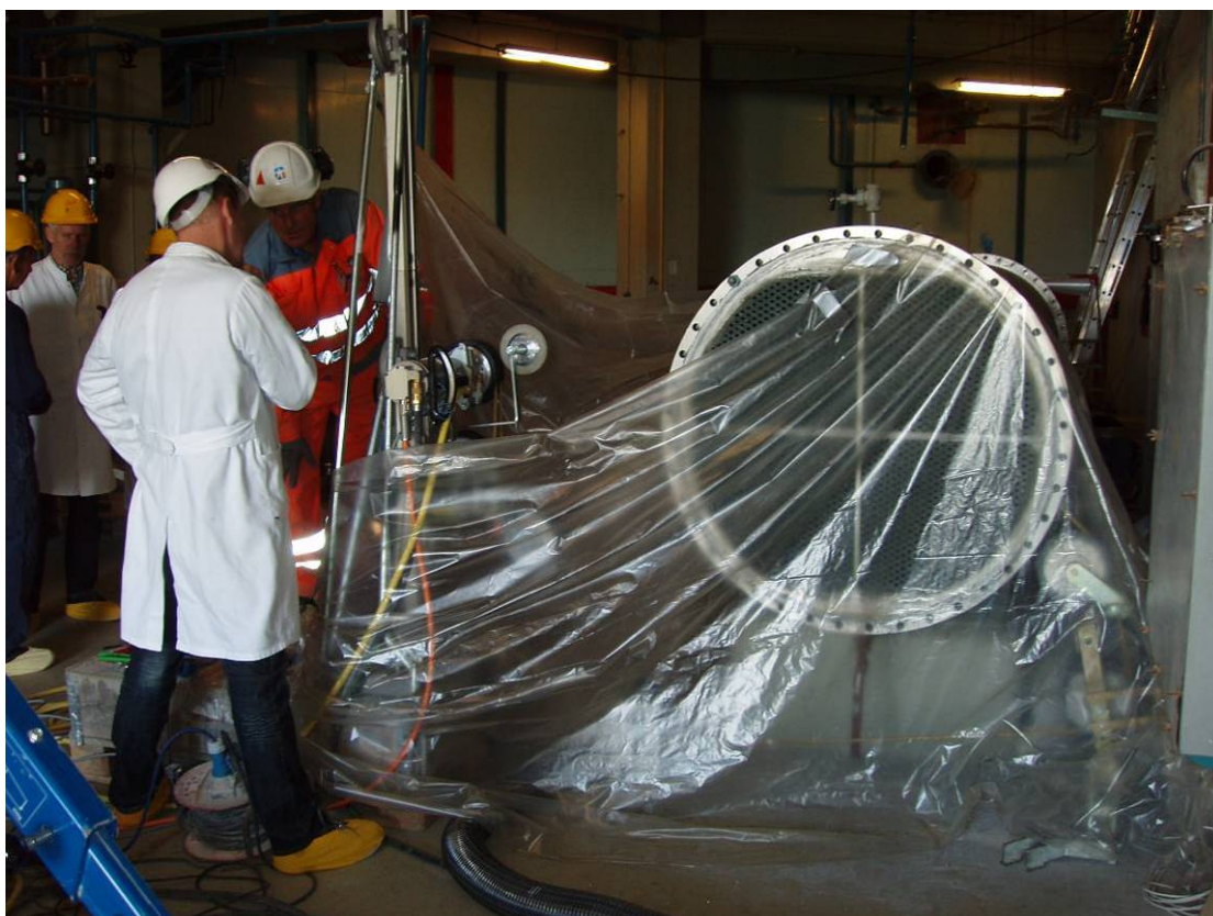
Figur 39 Opstilling for tør wireskæring af varmeveksler rør.
