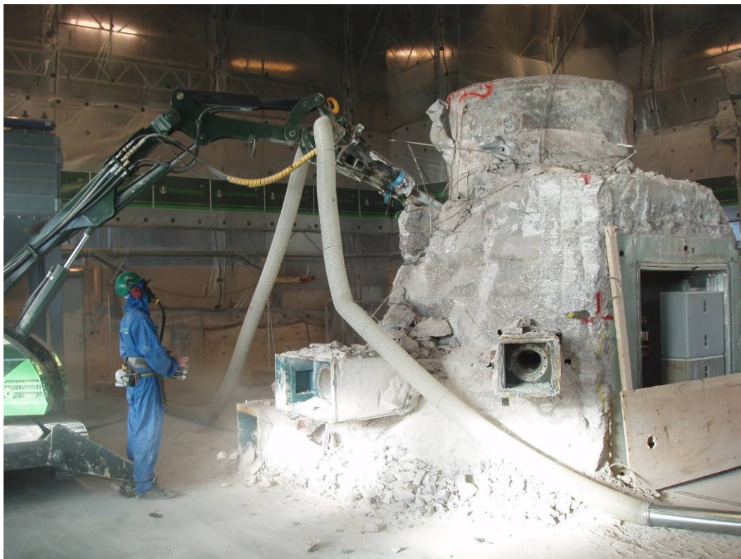
Figur 65 Nedrivning af aktiveret del af reaktorblok. Punktsug monteret til hydraulisk hammer.
