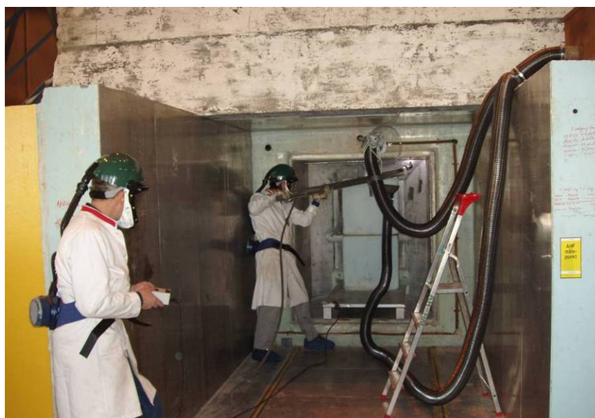
Figur 30 Plasmaskæring af blynæse. Afskærmningen med betonblokke ses i midten samt punkt udsugning.
