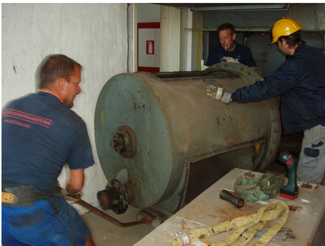
Figur 9 Udtagning af Gako ventil.
