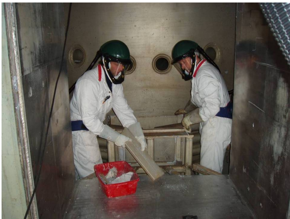
Figur 36 De sidste indre dele i reaktortanken fjernes.
