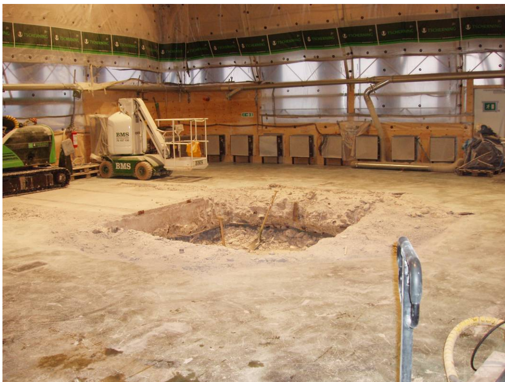
Figur 67 Reaktoren er fjernet. I baggrunden ses den sydlige teltvæg med udsugningsenheder ("miljøbokse").
