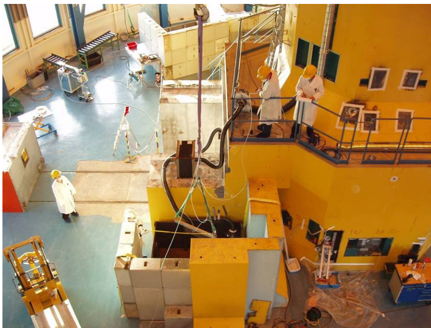
Figur 26 Arrangement for afskærmning og fjernbetjent håndtering af grafitudtagning og pakning af containere.
