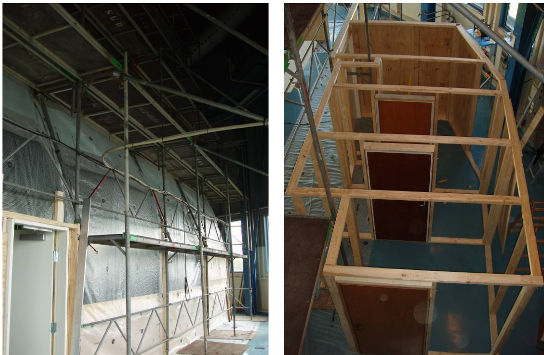
Figur 45 Stillads beklædt med presenning på inderside og personsluse i tre trin opbygges
