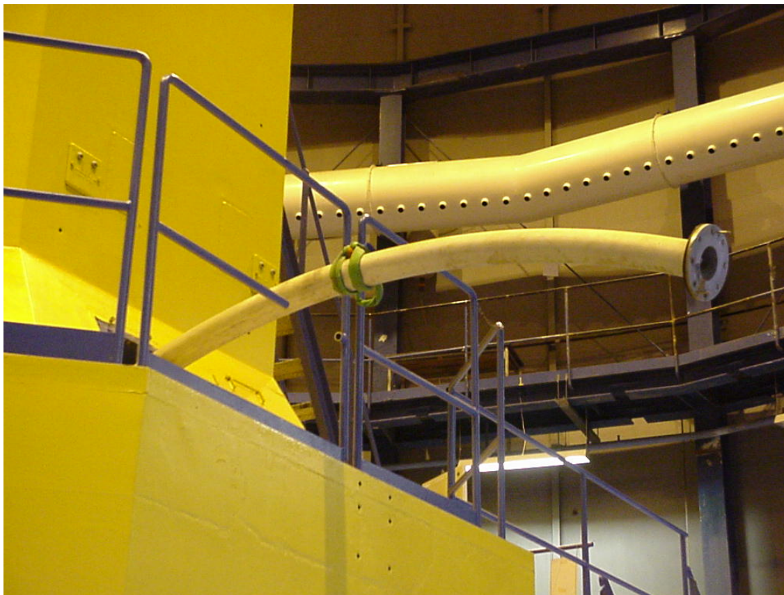
Figur 17 Udtagning af S-5 rør.
