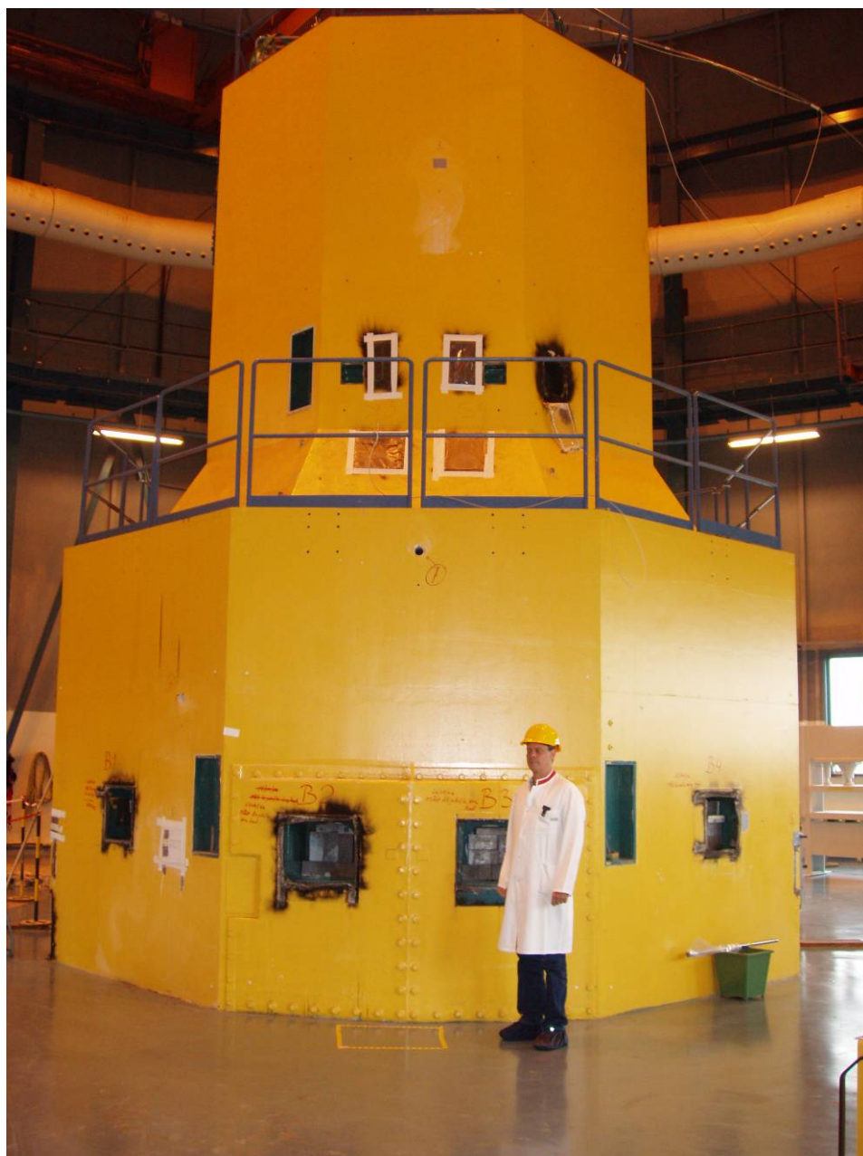
Figur 6 Reaktorblok og projektleder ved start af dekommissionering (juni 2006). Adgangsåbninger til forsøgsrør er afdækket.
