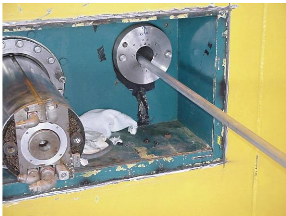
Figur 20 Udtagning af T-1 rør.
