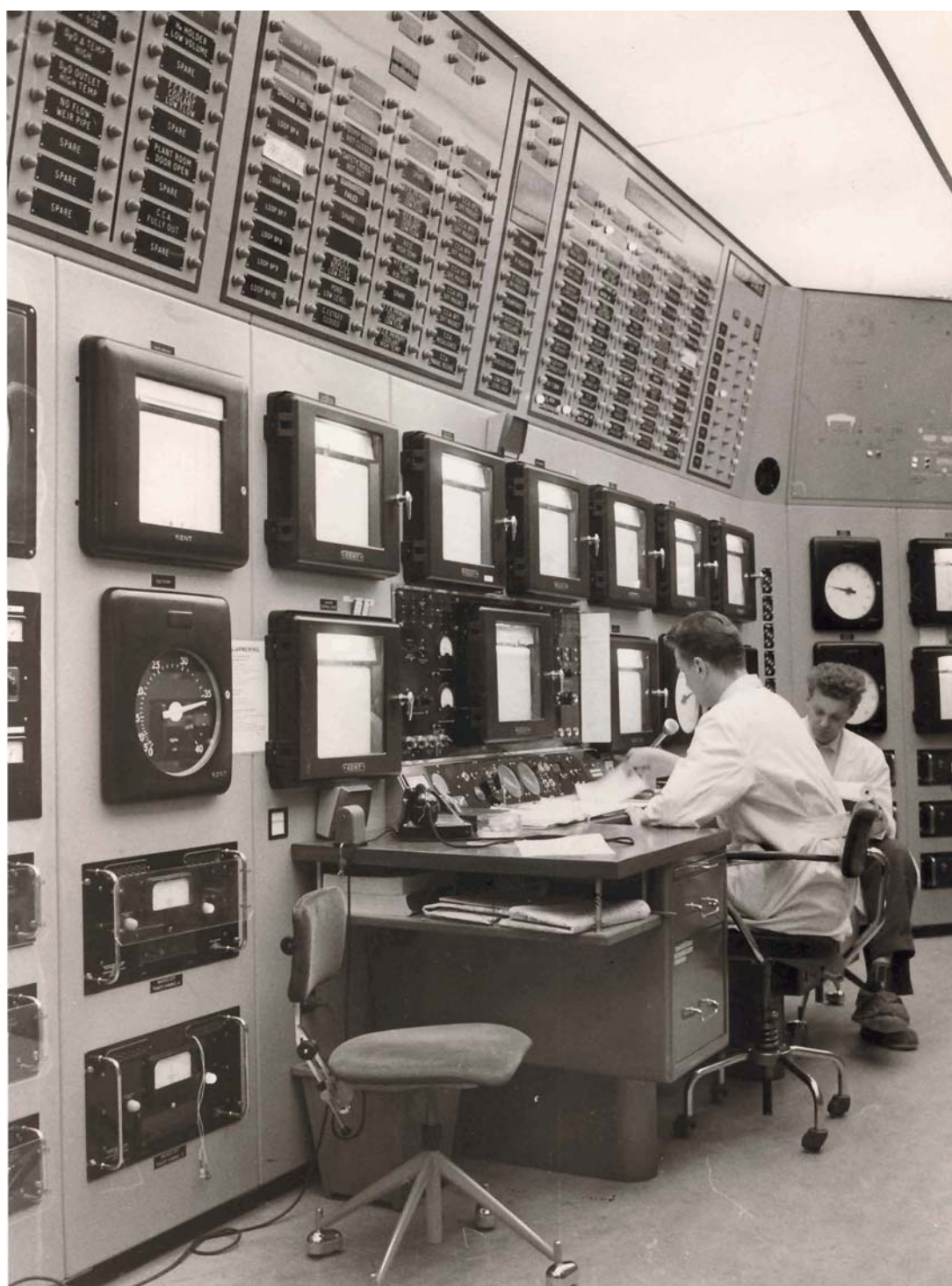
Figur 33. Et blik ind i DR3's kontrolrum i 1960'erne, hvor man ser kontrolrummets oprindelige instrumentering. Sammenlign evt. med figur 31, hvor man ser anden generations instrumenteringen. Flere af apparaterne er beskrevet i afsnit 4.4.
