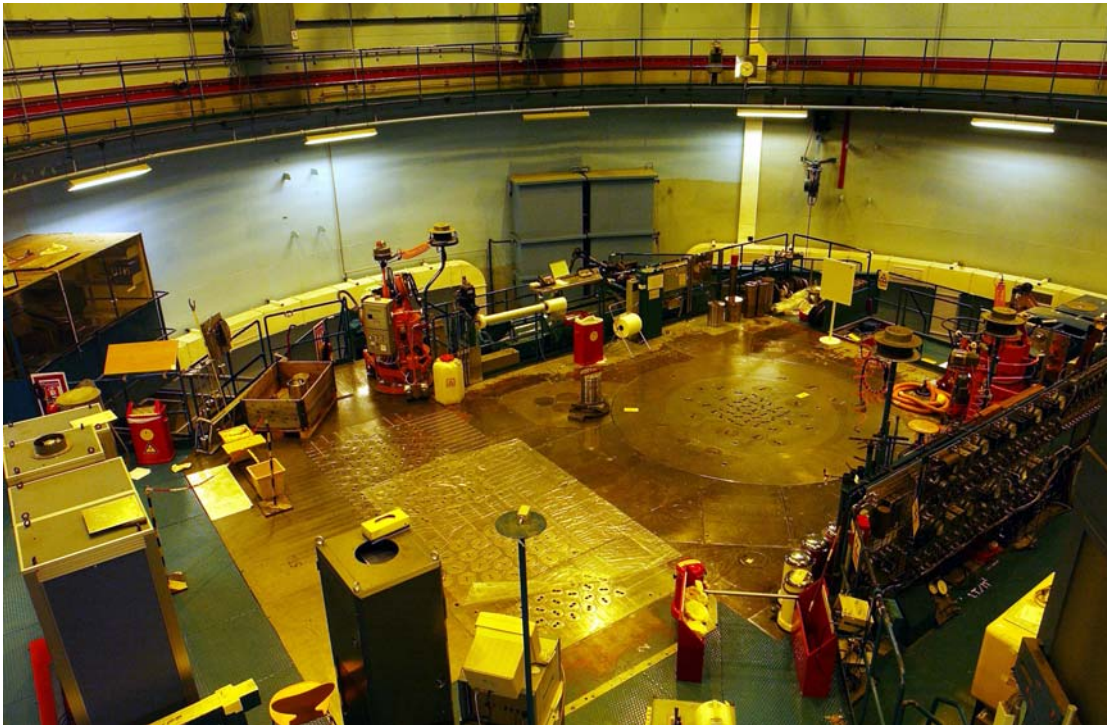
Figur 27. Et kig ud over reaktortoppen på DR3. Selve reaktoren befinder sig under den cirkelformede plade til højre i gulvet. Man kan også se rørene, hvorigennem brændselselementerne løbende blev udskiftet. Foto fra 2003, da reaktoren ikke mere var i drift.
