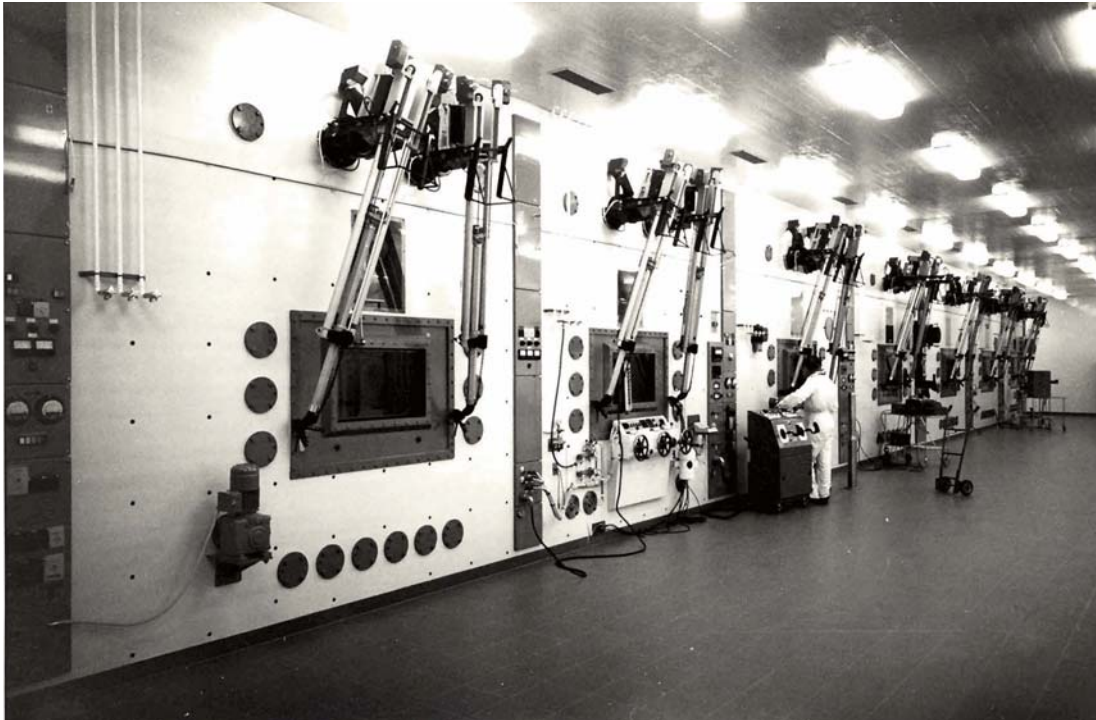
Figur 36: Arbejdet med kontaminerede eller aktiverede emner foregik ved Risøs Hot Cell anlæg bag tykke betonvægge og blyglasruder ved hjælp af fjernstyrede robotarme, såkaldte master-slave manipulatorer. Ukendt dato, formentlig fra 1960'erne
