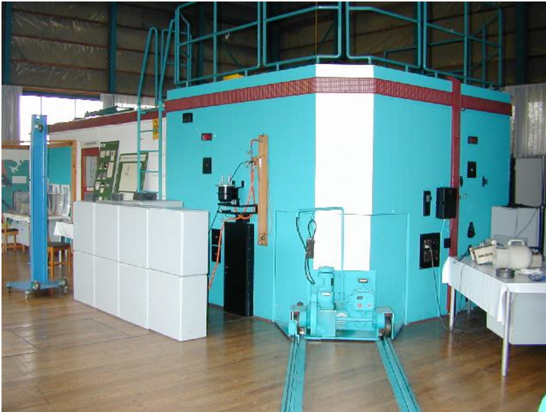
Figur 3. DR1 før dekommissioneringsarbejdet startede. Udskiftning af brændsel og anden løbende vedligeholdelse skete ved at åbne betondøren midt i billedet. Foto fra 2004.
