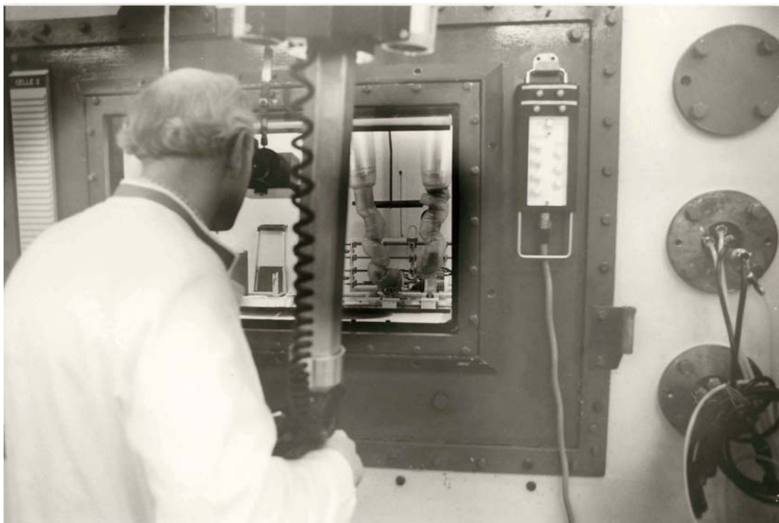
Figur 40. Arbejde med fjernbetjente master-slaves manipulatorer ved Hot Cell anlægget. Arbejdet kunne følges på tæt hold ved hjælp af en kikkert. Foto fra 1960'erne.
