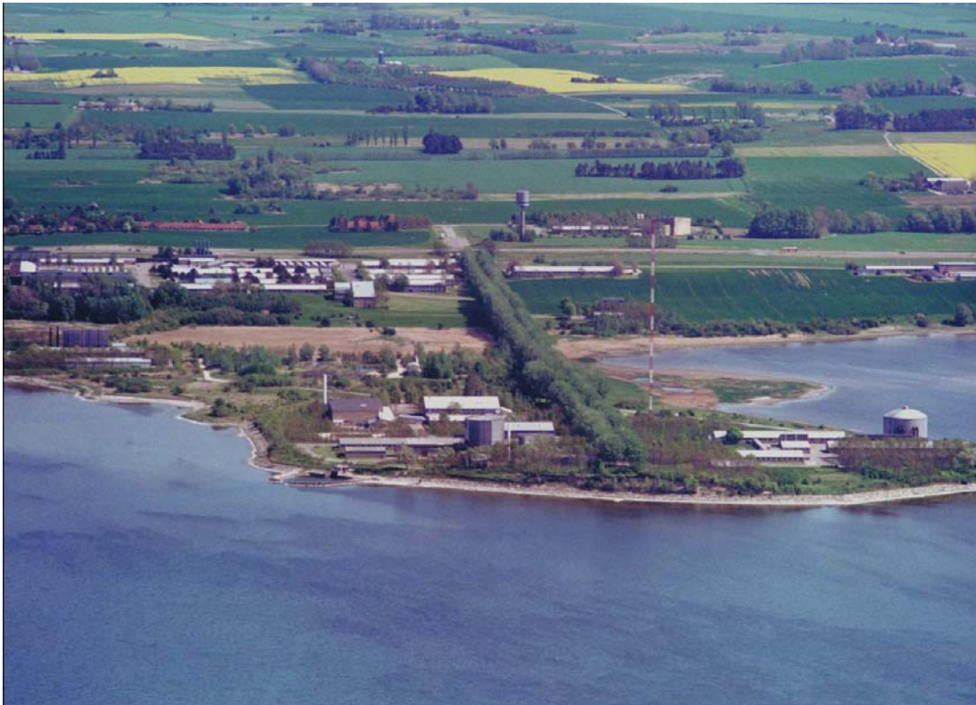
Figur 1. Luftfoto af Forskningscenter Risø. DR1 lå i den lille næsten skjulte bygning på højre side af halvøens basis. Reaktoren DR2 er placeret ude på spidsen af halvøen i den cylinderformede bygning helt til højre i billedet. Til venstre herfor, i midten af billedet, ses DR3's reaktorbygning og det hertil hørende bygningskompleks. Hot Cell anlægget, der i dag er forsegleet i beton, havde til huse i bygningerne umiddelbart ovenfor og lidt til venstre for DR3. Jf. i øvrigt figur 2.
