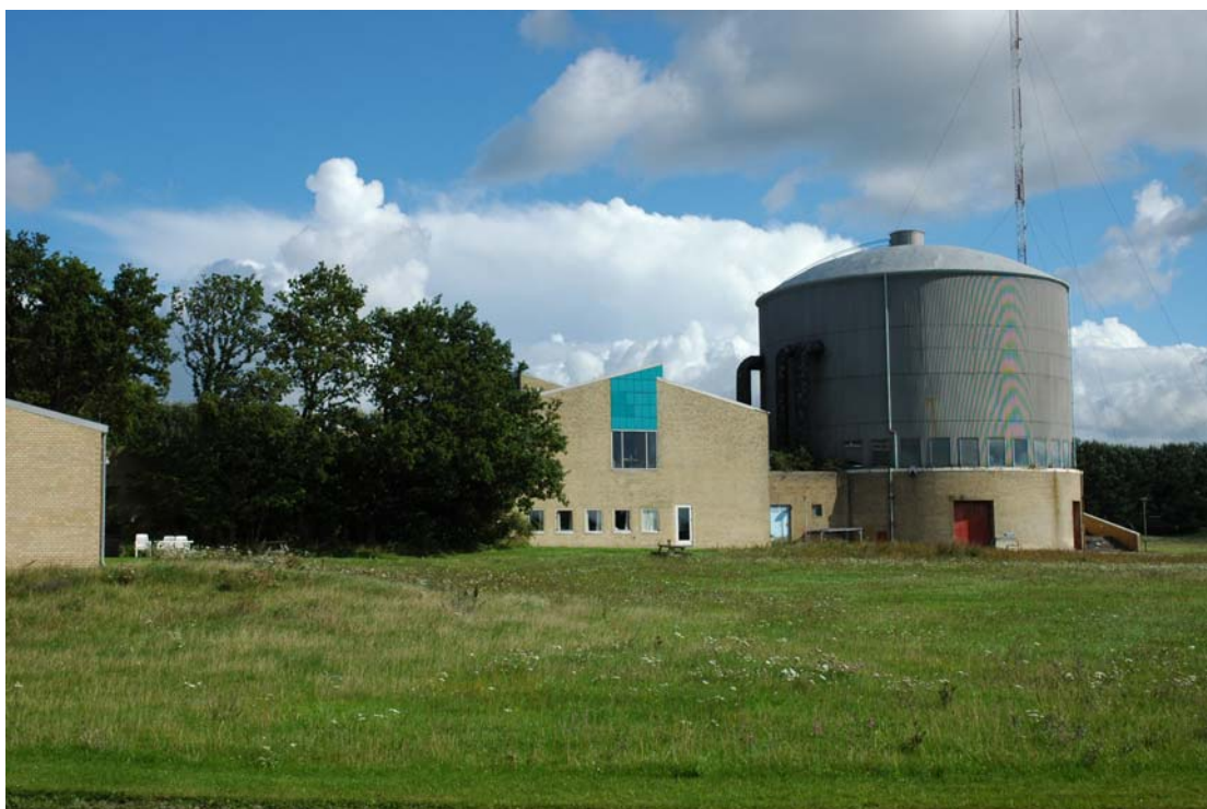
Figur 48. DR2 med de tilstødende bygninger, her set fra sydvest. Foto fra august 2006.
