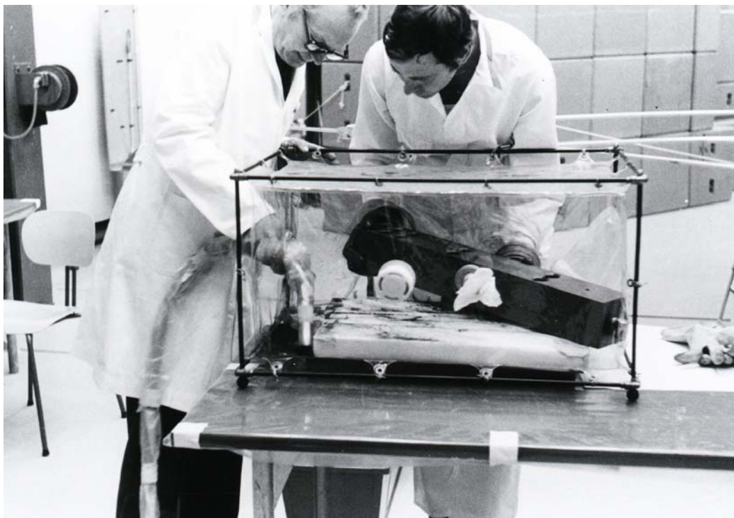
Figur 24. Grafitklodserne lige ud for kernen i den termiske kolonne modtog en høj mængde neutronstråling og havde derfor en tendens til at svulme op (fænomenet skyldes Wigner-effekten der forklares i afsnit 4.3.). Efter et forgæves forsøg på at renormalisere klodserne ved at gennemføre den såkaldte "annealing proces", gik man over til den simple løsning at slibe klodserne med smergellærred. Dette skete regelmæssigt, men det var en ret farlig procedure, der måtte foregå i handskekasse ("glovebox").
