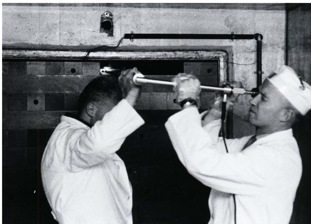
Figur 22. Aluminiumspladerne foran den termiske kolonne vendte direkte ind mod reaktorkernen og havde tendens til at korrodere. Her inspiceres pladerne ved hjælp af et endoskop. Man kan se, hvordan den termiske kolonne var opbygget af stablede grafitklodser. Foto fra 1960'erne.
